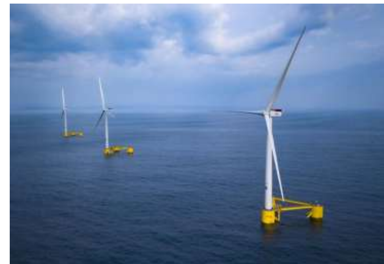
浮体式風力の事例 21年稼働47.5MW スコットランド
