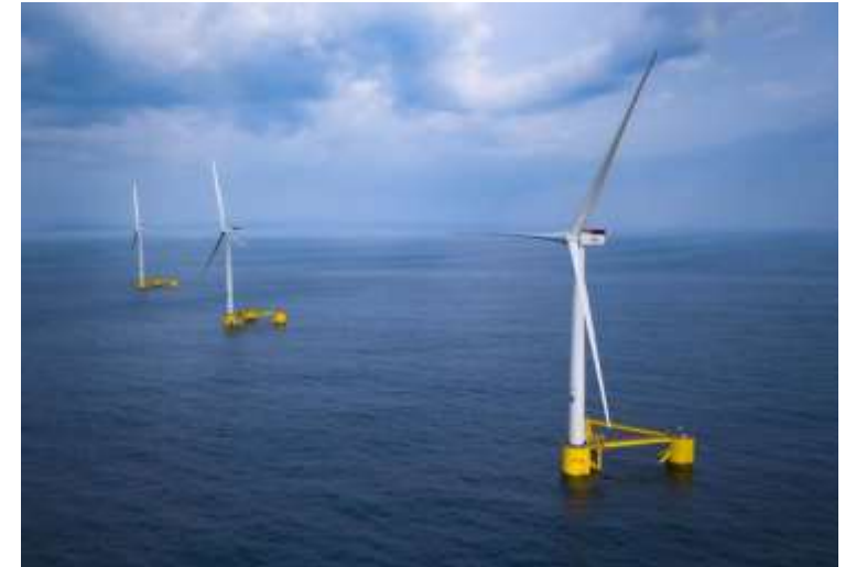
浮体式風力の事例 21年稼働47.5MW スコットランド
