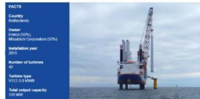
ルフタダウネン, オランダ (V112-3.0MW) 2015年
